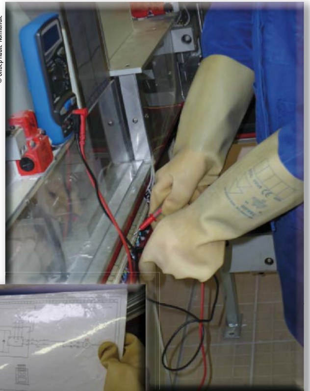
Diagnostic sur un système automatisé de production à l'aide d'un multimètre
