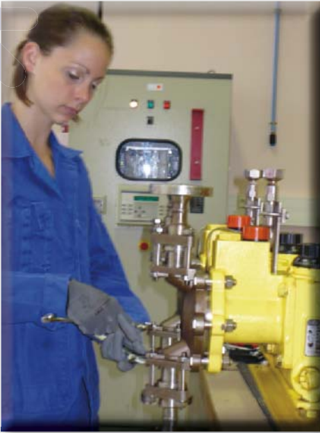
Opération de maintenance corrective sur une pompe
